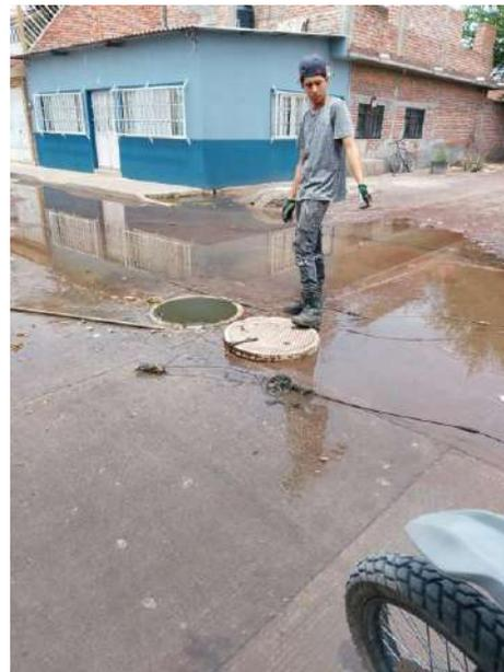
**DESAZOLVE DE DRENAJES MANUALMENTE CON VARILLAS**
